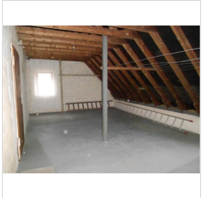
Dachgeschoss ausbfg. mit Fenst
